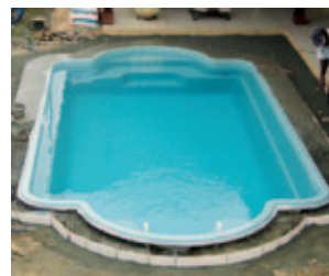
10 Réalisation d'une ceinture en béton armé.
