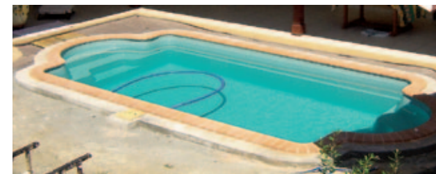
11 Mise en place d'une simple ou double margelle suivant vos souhaits.
