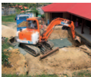
2 Terrassement et évacuation des terres.
