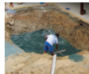
4 Réalisation du fond de forme.
