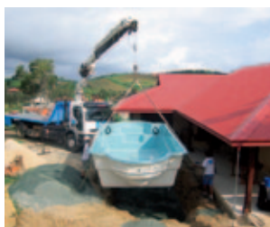
6 Grutage du bassin.
