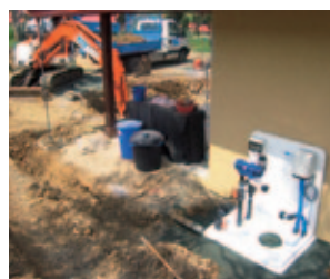
3 Mise en place du local technique.
