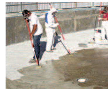
2° ENDUITS ET SOUS-COUCHE D'ACCROCHE
