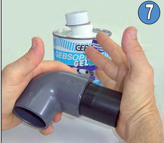
Ne pas oublier de contrôler le collage environ 1h plus tard, et vérifier si les parties n'ont pas bougé entre elles, vérifier les « trous d'épingles » et les manques de colle (refaire un bouchon si nécessaire).
